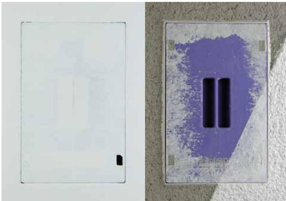
Fertig verputzte Wand, hier noch mit Bauschutz, welcher später entfernt wird
